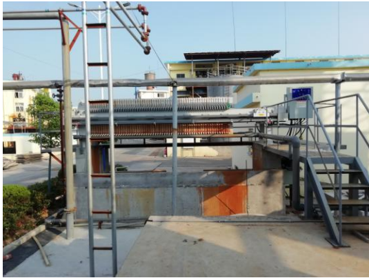
物化污泥池 ST-2
